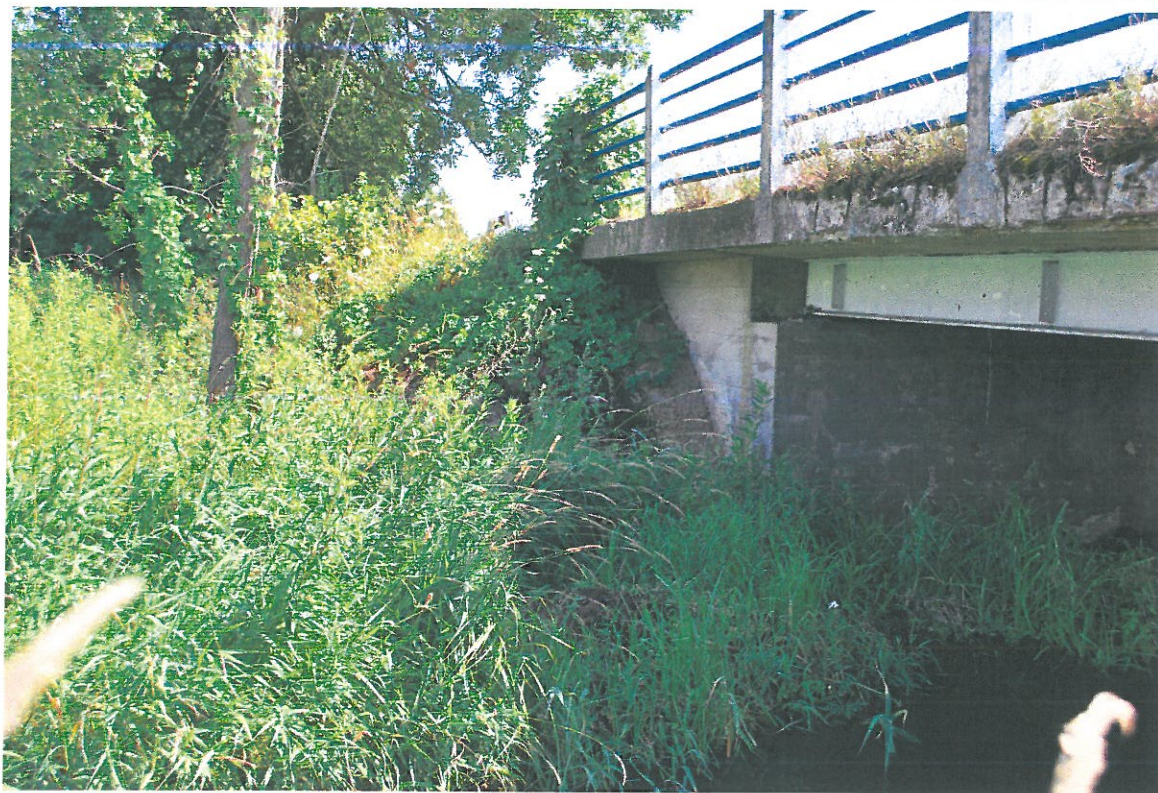
Fot. 5. Wegetacja roślin oraz zanieczyszczenia stożka spowodowane brakiem systematycznych prac utrzymaniowych - stożek od strony północnej i dolnej wody.
