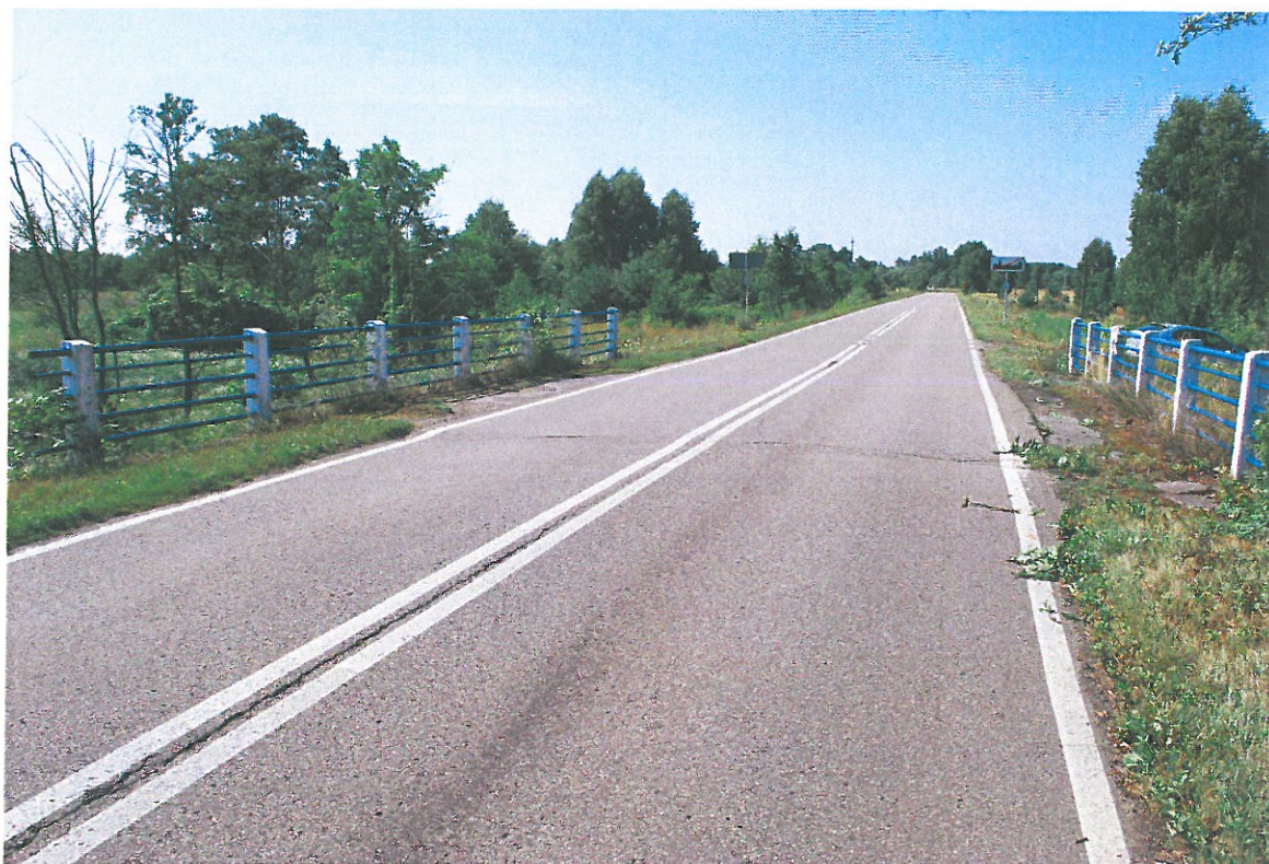
Fot. 1. Widok od strony północnej
