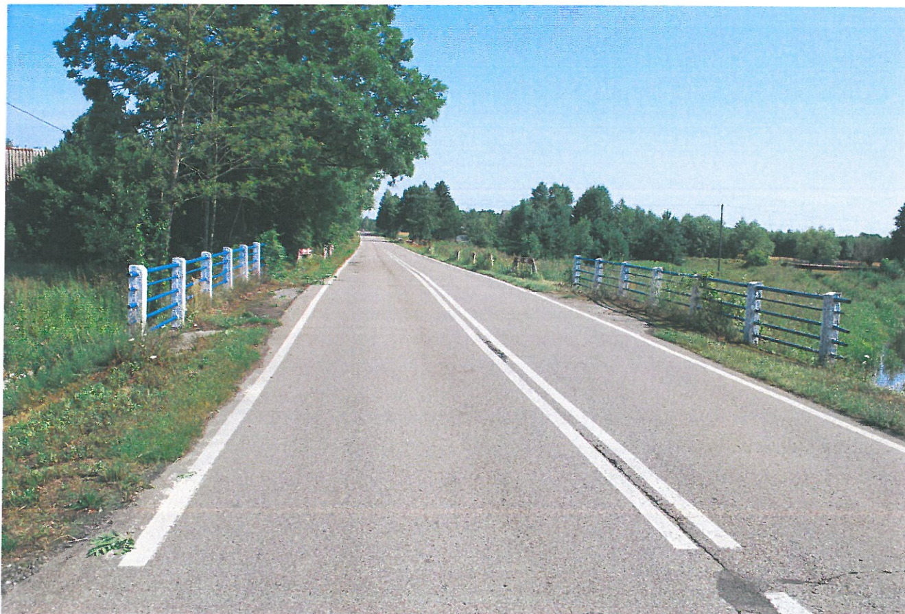
Widok ogólny mostu
